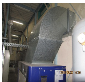
【⑫コンプレッサー排気ダクト取付】
