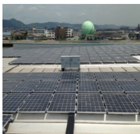
【⑧太陽光パネルの設置】
